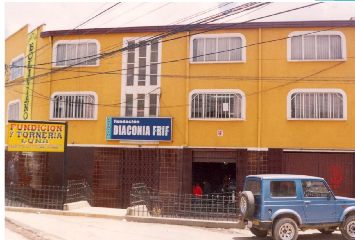
Antigua fachada de la casa de Av. Juan Pablo II, en la zona 16 de julio
