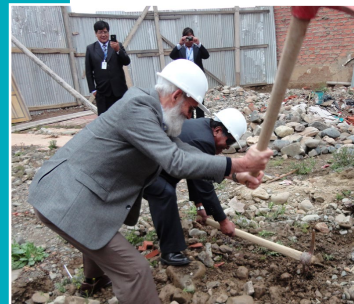
Los Hermanos Nils y Ricardo cavando los cimientos de lo que sería las oficinas centrales de Diaconía FRIF-IFD
